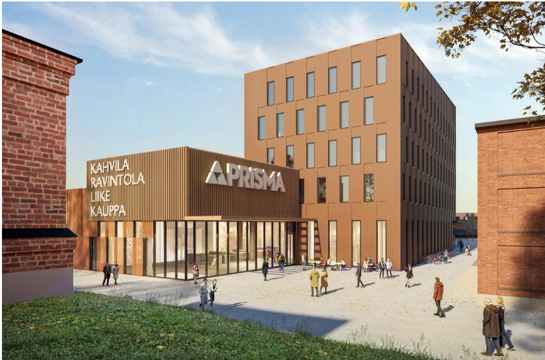
Kuva. Viitesuunnitelmassa esitetty näkemys Tiilikasarminaukion ja au-1 -osa-alueen toteutuksesta. Näin toteutettaessa syntyy pienierteinen aukio, jolla on hyvä pienilmasto. Korkotason tässä visualisoinnissa ovat vielä viimeistelemättä - tontilla oleva aukion osuus on noin kolme porrasta eli 0,5 m alempana muuta kevyen liikenteen ympäristöä.
